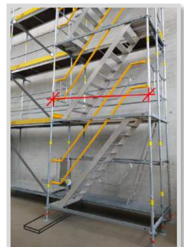
Abb. 4.7-36: Baugerüst mit zeichnerischen Ergänzungen
